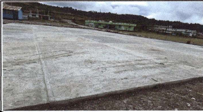
Foto 1: Sustitución de patio de torta de concreto
