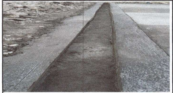
Foto 2: Reparación de cuneta de concreto
